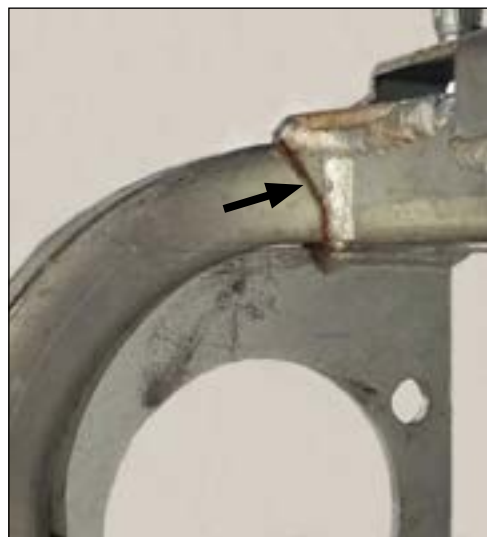
Figure 3 — Exemple de fissure dans un tube
