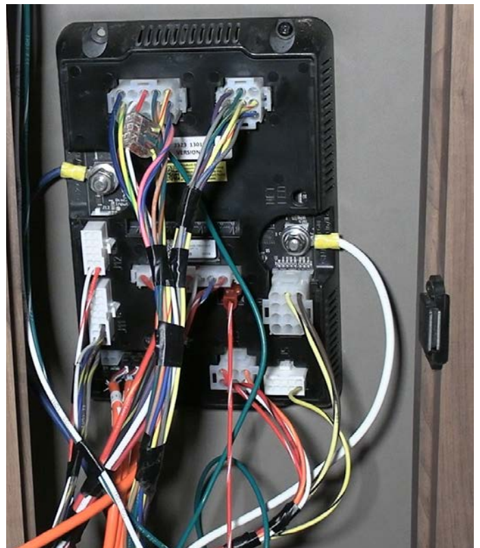
Panneau G12 monté dans le mur
