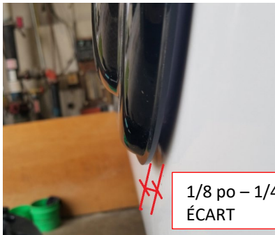
FIGURE 7 L'ESPACE ENTRE LA VITRE ET L'EXTÉRIEUR DU MUR DOIT ÊTRE DE 1/8 po – 1/4 po
