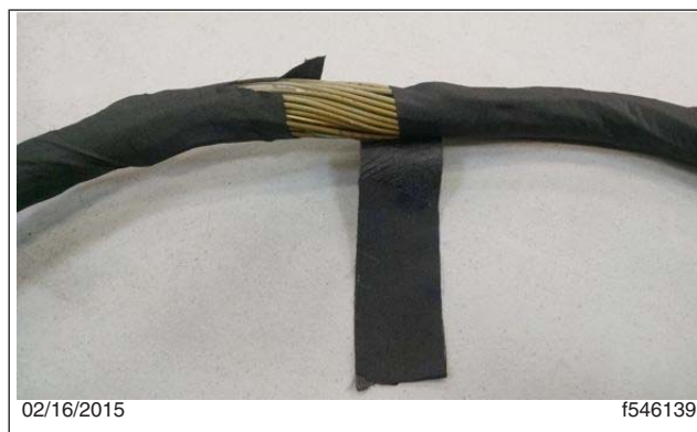
Fig. 5, Dégagement du faisceau de câblage de son enrobage
