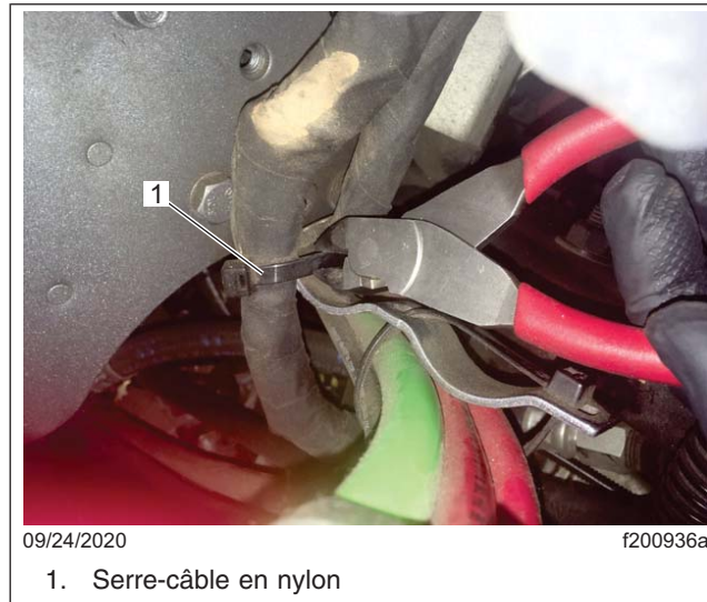
Fig. 15, Retrait d'un serre-câble en nylon du faisceau de câblage
