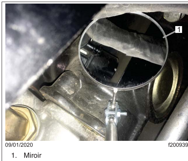
Fig. 2, Inspection avec un miroir
