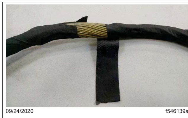
Fig. 19, Dégagement du faisceau de câblage de son enrobage
