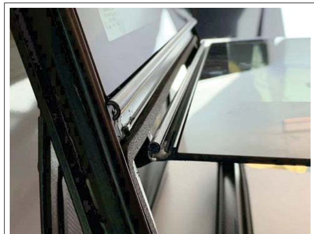
Fig. 2, Vitre dégagée de la charnière
