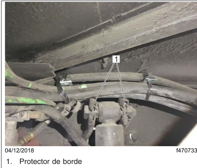
Fig. 17, Inspección del protector de borde
