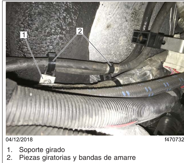
Fig. 6, Fijación de las mangueras al soporte girado
