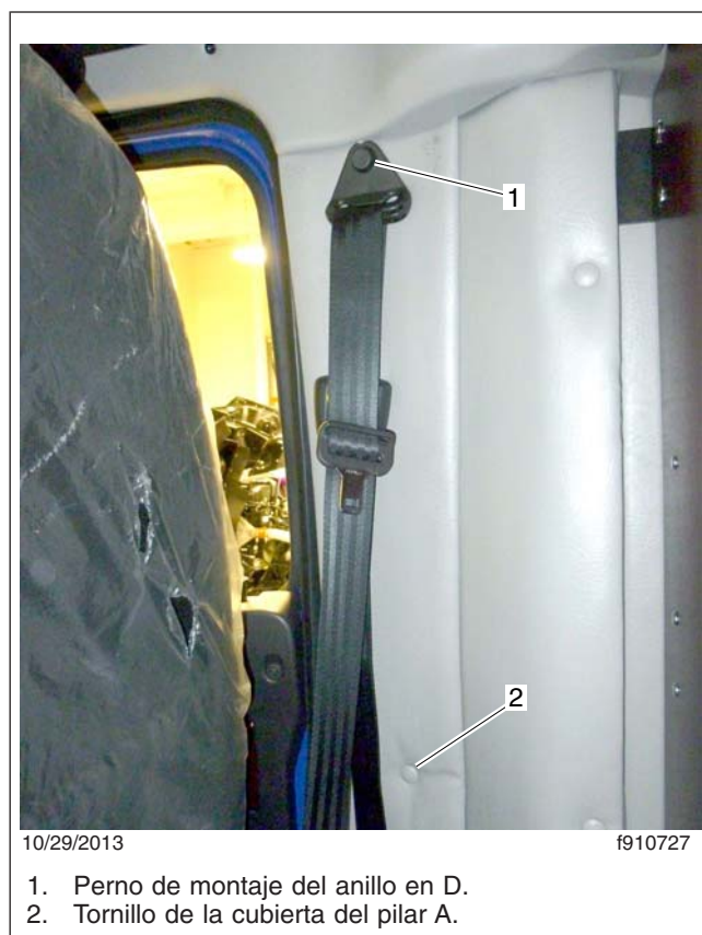
Fig. 6, Instalación del cinturón de seguridad
