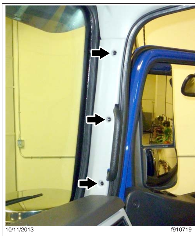
Fig. 3, Tornillos de la cubierta del pilar A
