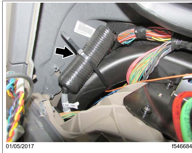
Fig. 24, Montage de l'ensemble de câbles au PLC
