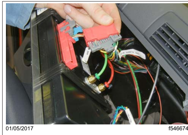
Fig. 14, Trabas del terminal del conector 2A de la ICU
