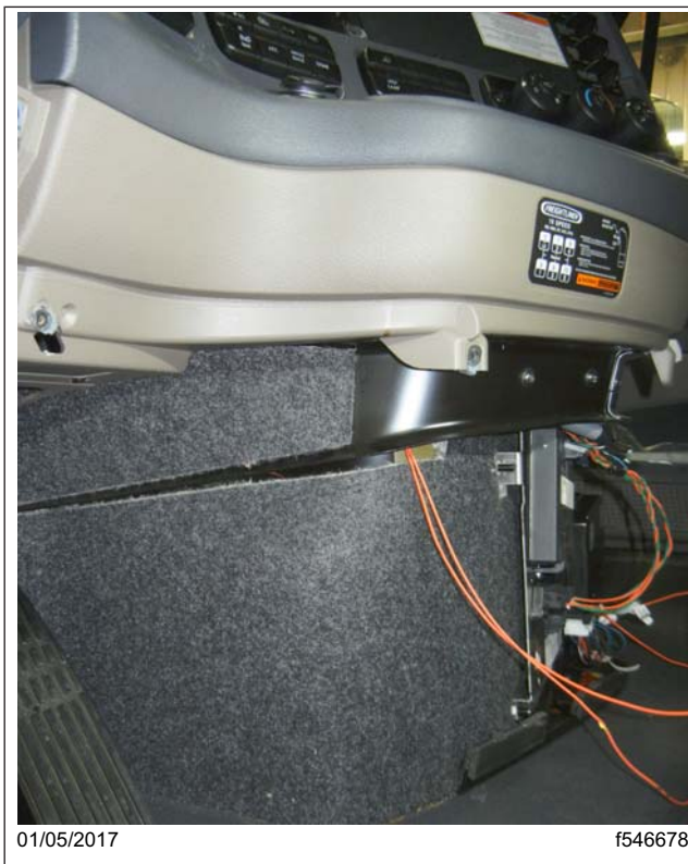
Fig. 18, Encaminamiento de los cables hasta el módulo del ABS (se muestra la instalación del FL721-A)
