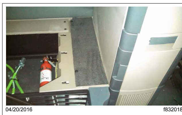
Fig. 3, Acceso a la unidad en los dormitorios de 48 y 60 pulgadas
