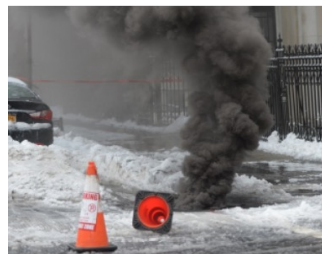
(h) Manhole fire
