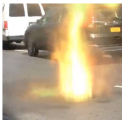
(j) Manhole explosion
